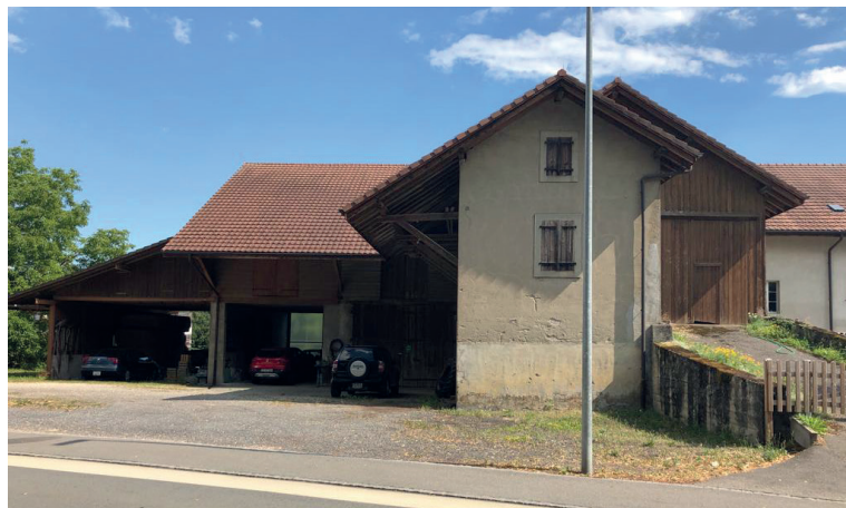
La ferme avant le début des travaux
