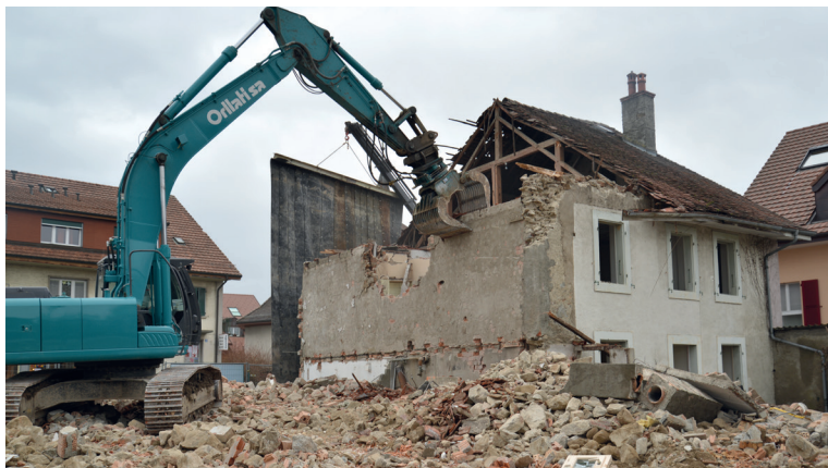
Puis la pelle mécanique s'attaque au toit de la maison Gross...
