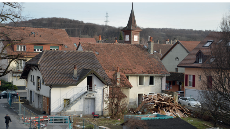
Le 31 janvier 2013, l'immeuble 4 jours avant sa démolition
